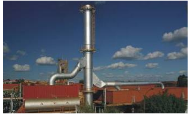
UNILEVER – Patos de Minas – SP: Sistema de exaustão das caldeiras a óleo.
