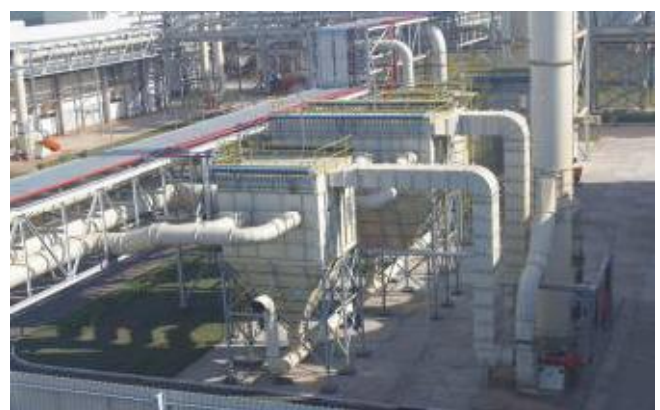
DURATEX – Botucatu – SP: Sistemas de despoeiramento da fábrica de MDF.
