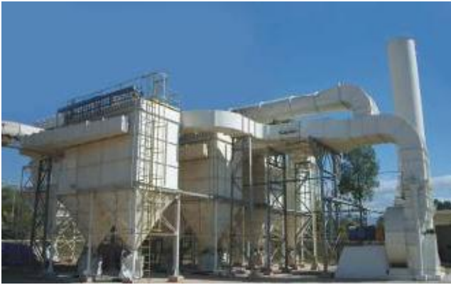
GRUPO SAINT- GOBAIN – Lorena – SP: Sistema de despoeiramento fornos eletrofusão de bauxita.
