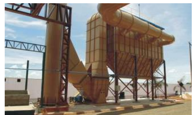
COPLANA – Jaboticabal – SP: Sistemas de despoeiramento beneficiamento de amendoim.
