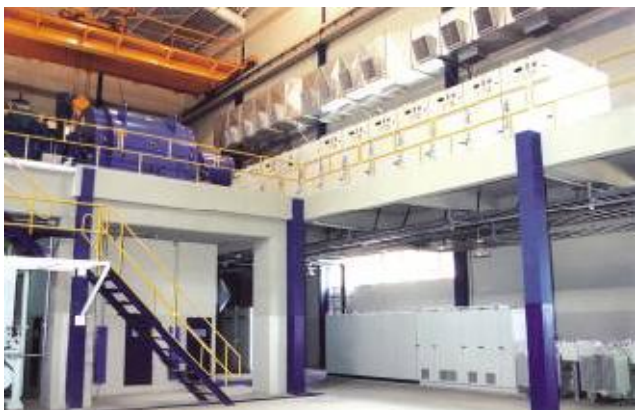
USINA CERRADINHO – Catanduva – SP: Sistema de ventilação e pressurização da casa de força.
